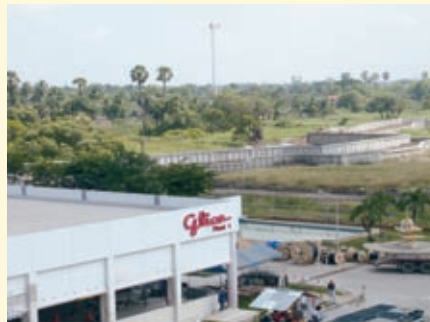
バンカディ工場の 周囲に設置された 防水堤
