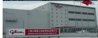
南奉第3工場/2008年 竣工
