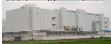
南奉第4工場/2010年 竣工
