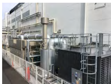
神戸工場コージェネレーションシステム 液化天然ガスに燃料転換したボイラー
