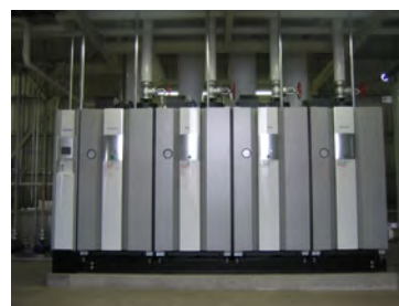
神戸工場コージェネレーションシステム 液化天然ガスに燃料転換したボイラー
