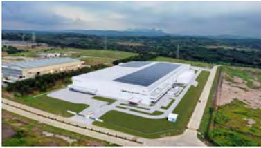
『Pocky』の最新鋭技術が詰まった新工場、Glico Manufacturing Indonesia が2022年3月末に完成しました。敷地面積は約6万㎡、建物の延床面積は約5万7,000㎡で、『Pocky』の自社工場として過去最大規模です。太陽光パネルを屋根に設置し、2024年度の発電量は119万kWh、年間で約1,038tのCO<sub>2</sub>排出削減に貢献しました。
